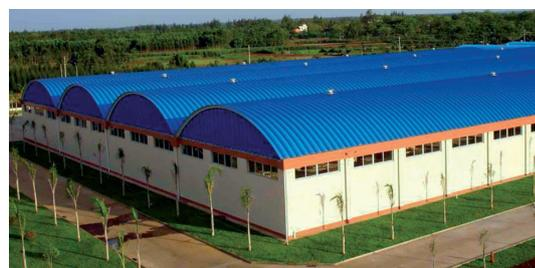
3. **CUBIERTA AUTOPORTANTE RECTA:** Sistema de cubierta de canalón de chapa recta autoportante (ABM 680) cubriendo solamente el techo (sin paredes). Las paredes pueden ser de hormigón o estructura metálica.
